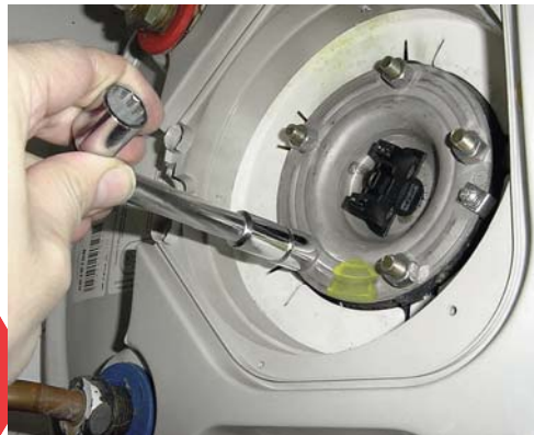
3 - Dévissez la platine électrique.
