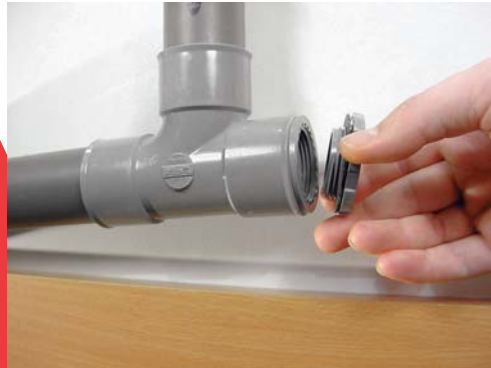
1 - Dévissez le bouchon du tampon de visite.
