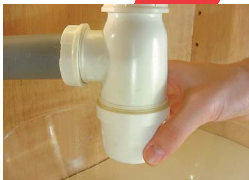
2 - Dévissez le culot du siphon, laissez l'eau s'écouler.
