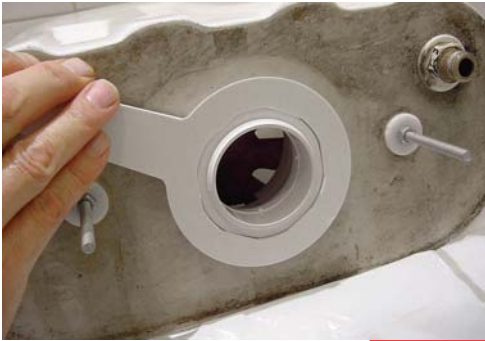
7 - Vissez le nouveau siège de la cloche avec la clé en plastique fournie dans le kit.
