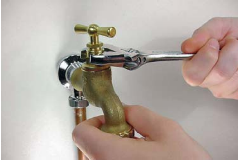
1 - Coupez l'arrivée d'eau au compteur, puis dévissez la tête du robinet à l'aide d'une clé à molette.
