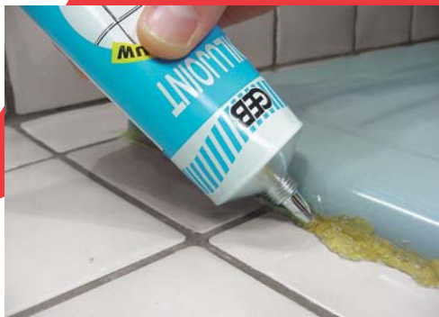
3 - Appliquez généreusement le dissolvant.
