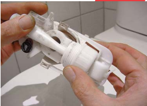
2 - Démontez la tête du robinet flotteur.
