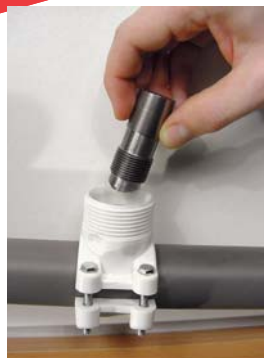
5 - Percez la canalisation avec l'emporte-pièce.
