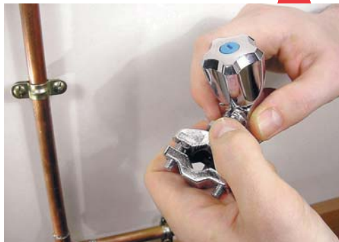
1 - Démontez la bride du robinet autoperceur.
