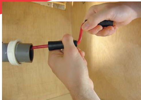
6 - Tournez la manivelle pour éliminer le bouchon.
