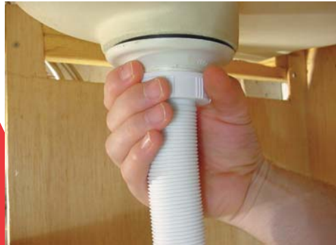
3 - Serrez l'écrou du flexible sur la bonde.
