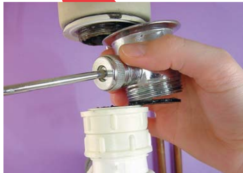
5 - Dévissez l'élément inférieur de la bonde.
