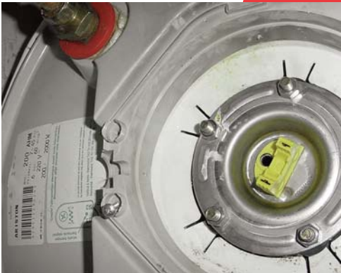
7 - Changez le joint et remontez la platine.
