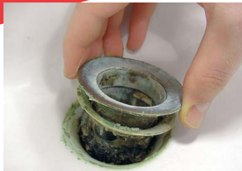
6 - Retirez l'élément supérieur de la bonde.
