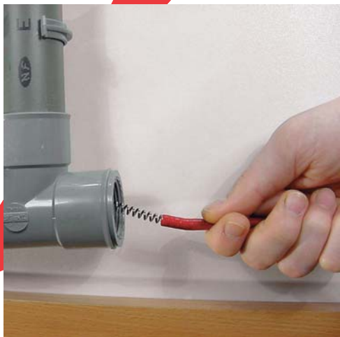
2 - Introduisez l'embout du furet dans la canalisation.
