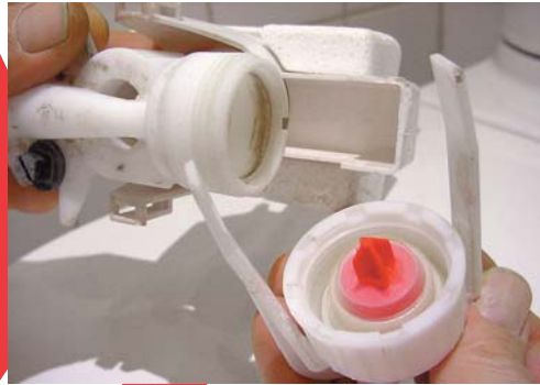
4 - Remontez la tête avec sa nouvelle membrane.
