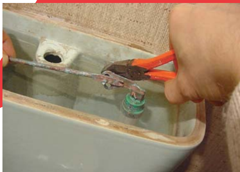
3 - Serrez l'écrou de réglage.
