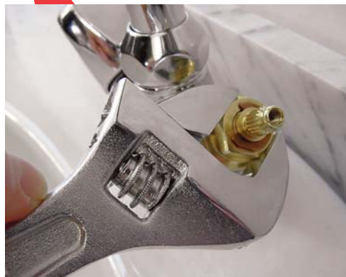
2 - Serrez fermement la tête dans le corps du robinet.
