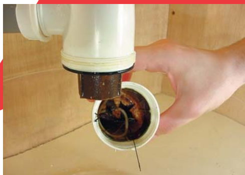
3 - Nettoyez le culot et l'intérieur du siphon.
