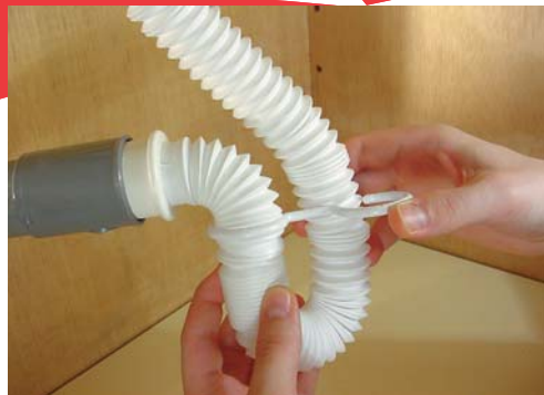
5 - Collez le flexible dans le manchon, puis clipsez la bague sur le flexible pour qu'il garde sa forme.
