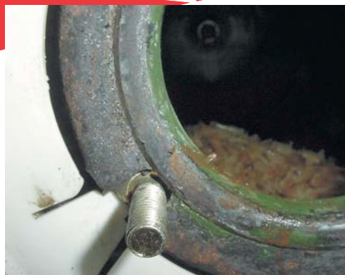
5 - Vérifiez l'état de la cuve et la quantité de tartre.
