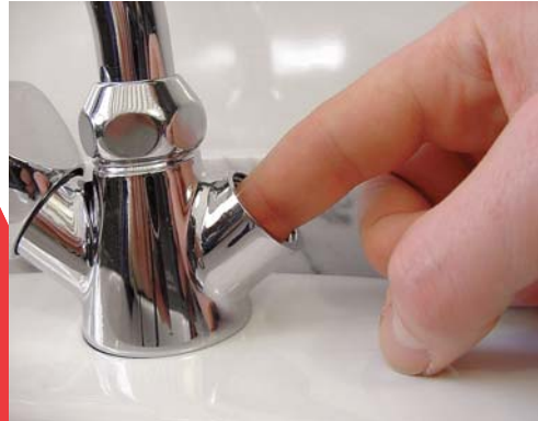
1 - Vérifiez l'état du siège avec le doigt.
