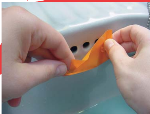
3 - Collez-la sur l'orifice du trop-plein.
