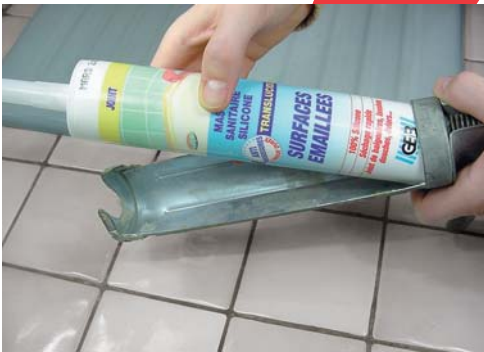
2 - Installez la cartouche dans le pistolet.
