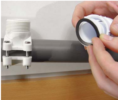
7 - Placez le joint sur le siphon.
