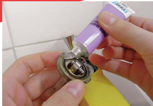
6 - Enduisez les pièces mécaniques de graisse au silicone. N'endiguez pas les disques céramiques !
