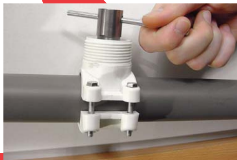
5 - Percez la canalisation avec l'emporte-pièce.
