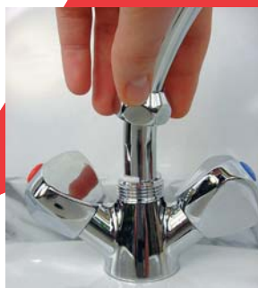
1 - En cas de fuite, dévissez l'écrou et retirez le col de cygne.
