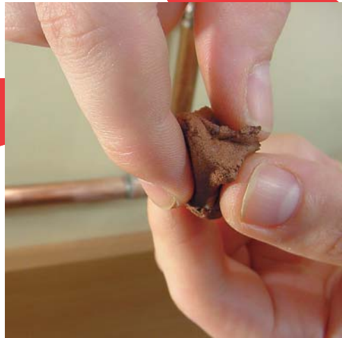
4 - Malaxez la pâte pendant une trentaine de secondes. Sa teinte doit être uniforme.
