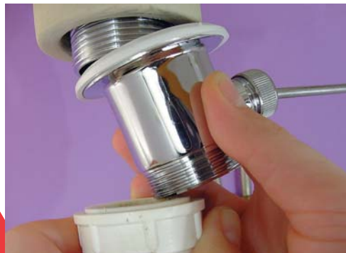
10 - Disposez le joint d'étanchéité, puis vissez l'élément inférieur, tige vers l'arrière.
