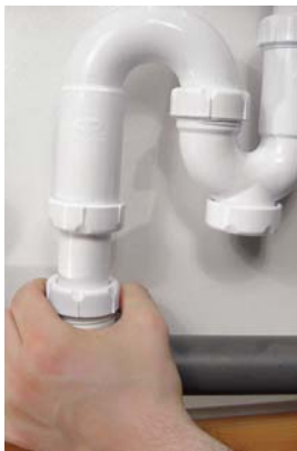
7 - Placez le joint sur le siphon.
